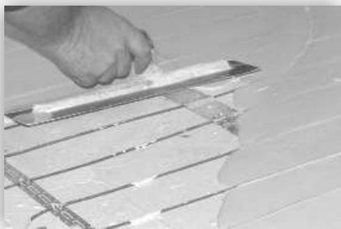
**Paso 6. TENDIDO DEL CABLE LX** Coloque el cable de manera que el punto de conexión y el sensor de temperatura estén en sus debidas posiciones y lleve el cable de alimentación al termostato o la caja de conexiones.
