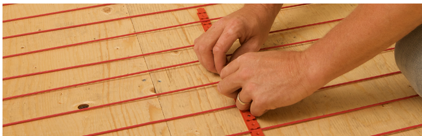
FIGURE 2.29 : Installer les guides de stabilisation
