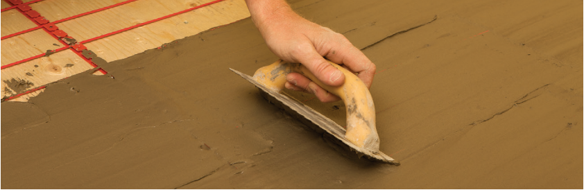
FIGURE 2.52 : Méthode du mortier à pose simplifiée
